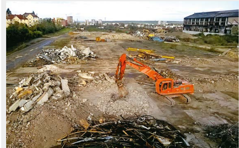
Plus de 16 000 tonnes de béton ont été concassées pour déconstruire les locaux de l'ex-usine Sulzer.
