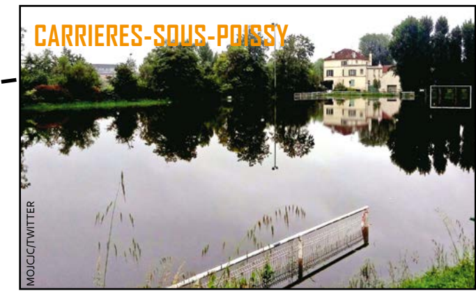
CARRIERES-SOUS-POISSY Si les logements du quartier des bords de Seine ont échappé à la crue de la Seine, cela n'a pas été le cas de leurs parkings, prévus comme d'éventuels réservoirs lors de l'érection du nouveau quartier. Ce sont environ 1 400 véhicules qui ont dû être déplacés vendredi et samedi. Dans de nombreux autres quartiers, l'eau est remontée par capillarité dans les caves comme au niveau de certains équipements sportifs (photo ci-dessus).
