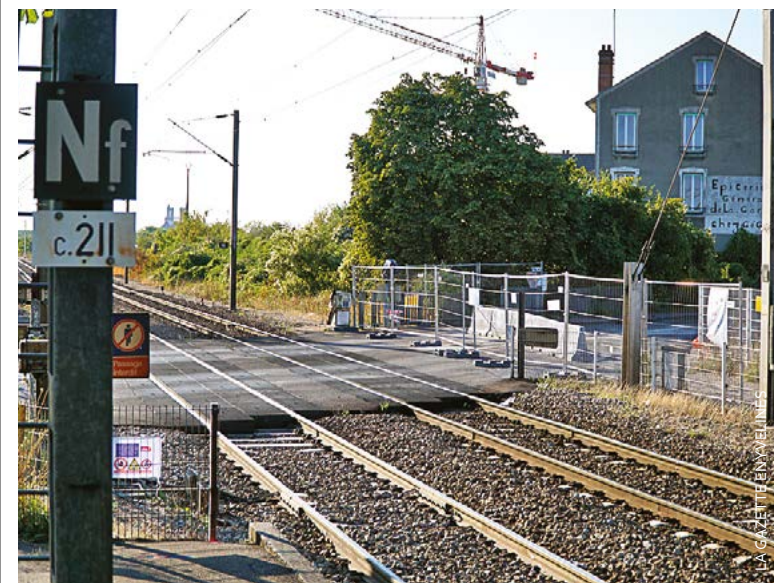
Dès la fin du mois d'août, l'accès par le passage à niveau avait été condamné.
