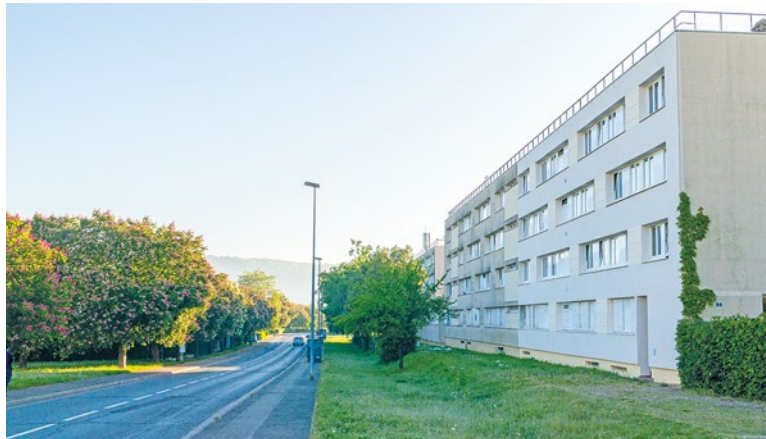
Le chantier devrait être lancé au début du mois d'avril, après des travaux préparatoires, pour une durée de 23 mois. La livraison est ainsi estimée au printemps 2022.
