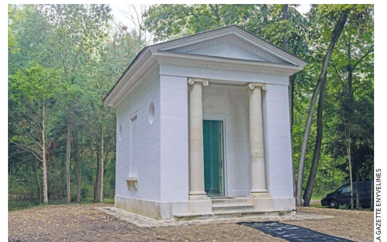
Le temple de David est un des plus anciens temples maçonniques connus sur le territoire national. Selon l'architecte du patrimoine, Riccardo Giordano, sa restauration a nécessité un véritable travail d'archives pour lui redonner, le plus fidèlement possible, son aspect originel.
