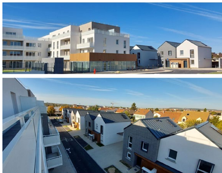
@Montesson - Construction de 110 logements
