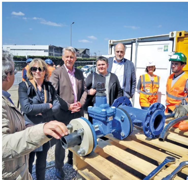
Les travaux devraient prendre fin dans le courant du mois de juin.
