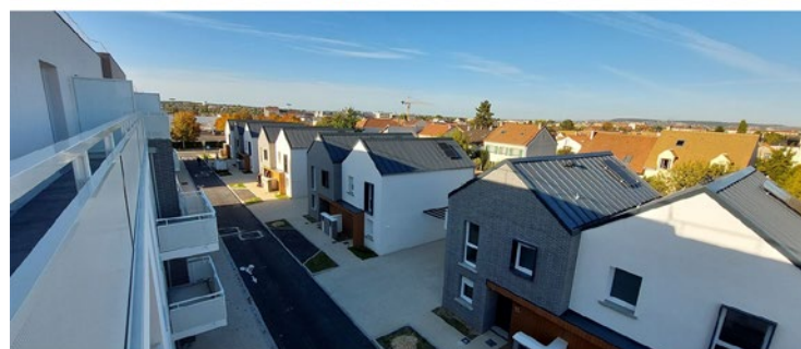
@Montesson - Construction de 110 logements
