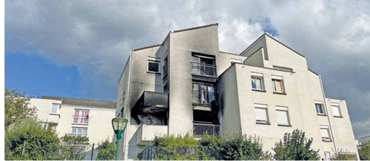
Sur place, pompiers et secouristes se pressent afin d'évacuer la quatre-vingtaine de personnes. Aucun n'a pu réintégrer son domicile à l'issue de l'intervention des secours, vers 22 h 30.
