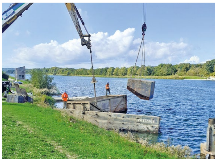
Le but de ses travaux est d'aplanir et harmoniser le bassin à 3 mètres de profondeur, reprendre et stabiliser les berges, rénover et remplacer les pontons d'embarcation.
