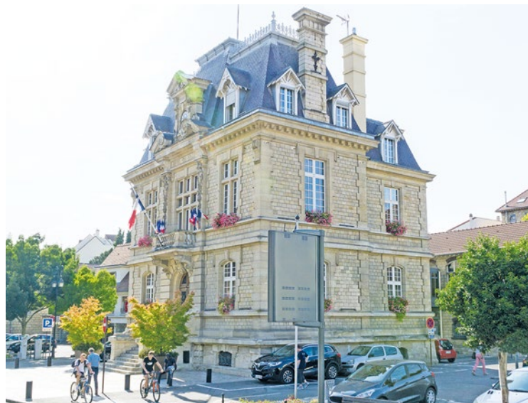
Depuis 2015, la Ville a engagé plusieurs travaux afin de réduire sa consommation d'énergie.
