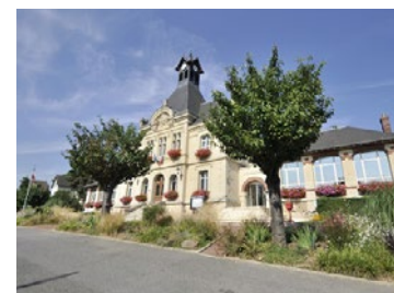
Du 22 avril au 3 mai, il n'y aura plus de circulation automobile durant les horaires de rentrée et de sortie scolaire dans la rue Janine Vins.
