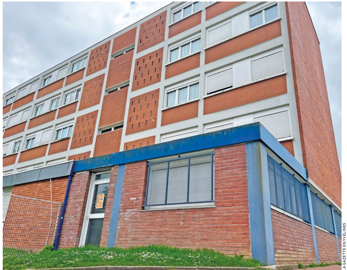
La salle située au 60, rue du plateau était devenue trop petite pour les musulmans pratiquants de la commune d'Aubergenville.
