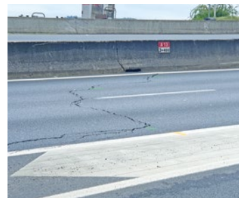
Les équipes de la Dirif s'occupent de consolider le tronçon abimé par les fissures.
