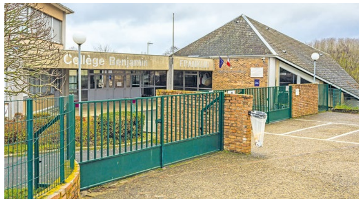
Malgré la réduction des effectifs maximum pour le collège Benjamin Franklin, le Département assure que les hauts standards de construction seront respectés.
