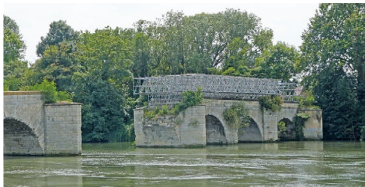
La mise en service de la passerelle piétonne est prévue pour le courant de l'année 2026.
