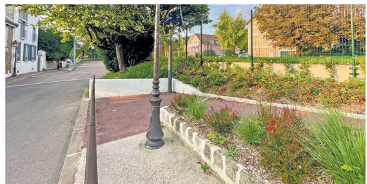
Un petit détail a retenu l'attention des usagers sur la nouvelle rampe d'accès dédiée aux personnes à mobilité réduite...
