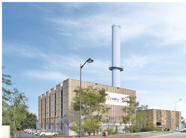
Les travaux de développement du réseau seront réalisés d'ici 2030. En complément, une consultation participative sera lancée pour déterminer le nom du réseau de chaleur et son logo.
