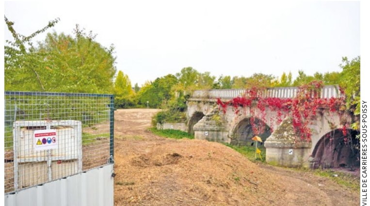
Une base vie pour les ouvriers doit enfin être installée d'ici le 12 novembre 2025.
