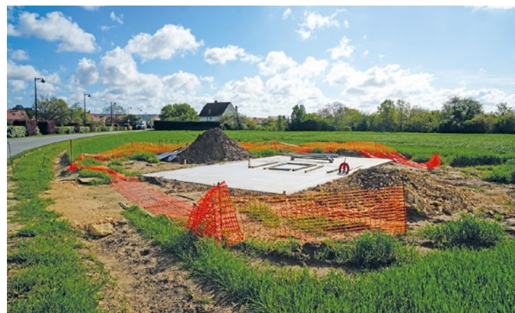
En s'approchant de la dalle en béton jouxtant la route près des terrains de football, à Verneuil-sur-Seine, on pouvait apercevoir un message équivoque, inscrit à l'aide de planches de bois : « NON ».
