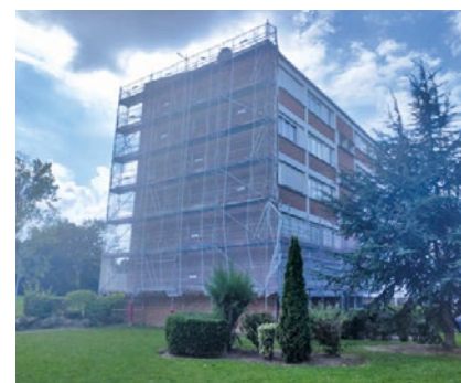
L'installation des échafaudages a été réalisée courant septembre.
