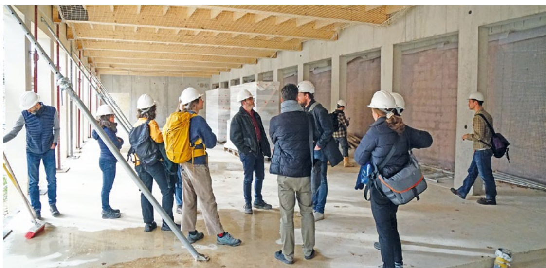
La salle du conseil municipal pourra se transformer en trois salles de réunion grâce à des panneaux latéraux.
