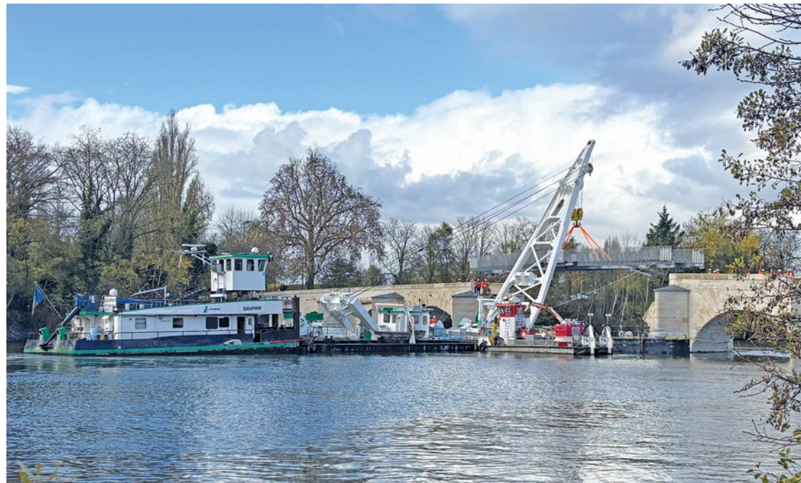
La structure en acier de la passerelle a été assemblée dans les Vosges puis a stationné au port autonome de Limay, avant de venir se jucher sur le Vieux Pont.
