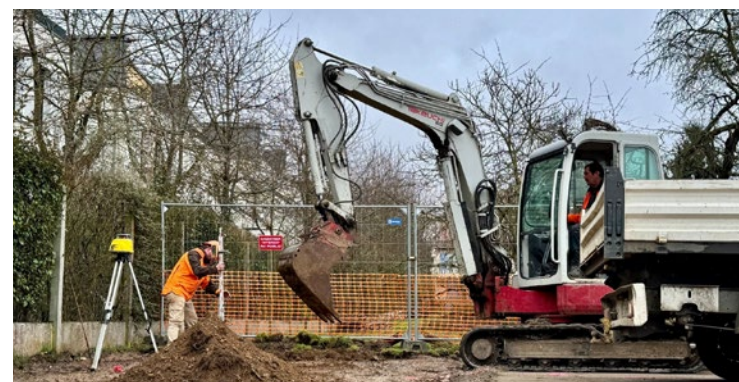
La Ville fera des points travaux réguliers pour suivre l'avancée du chantier.
