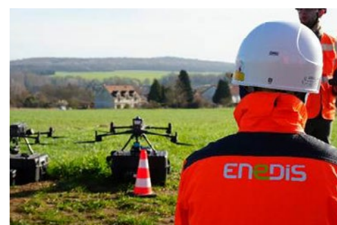
La prestation réalisée portait sur le contrôle des distances de sécurité indispensables entre les arbres et les lignes électriques.
