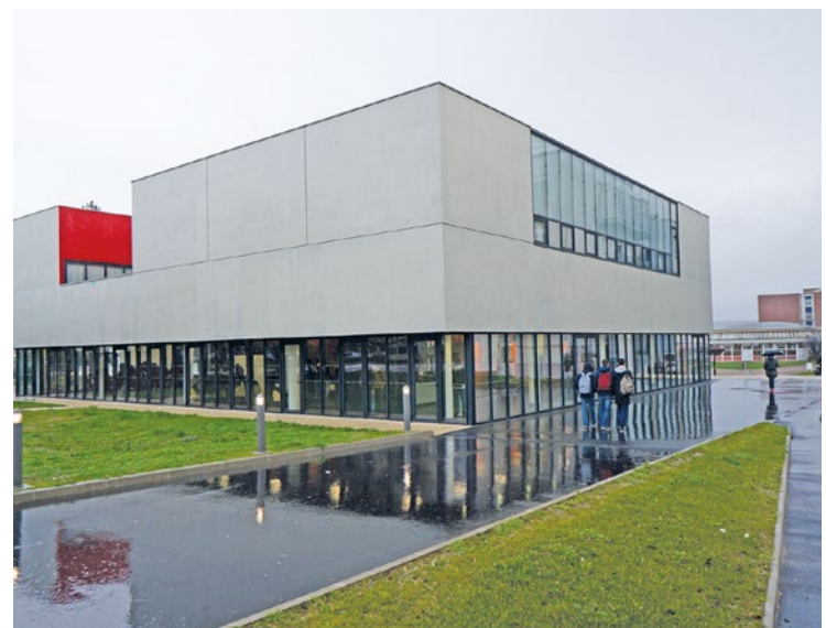
Le personnel dénonce des conditions d'enseignement dégradées ainsi que des éléments de sécurité défaillants.
