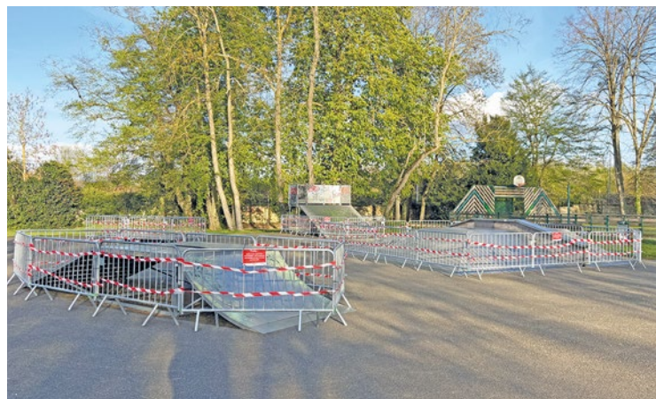
Les structures situées à côté du city-stade ont été fermées définitivement pour des raisons de sécurité.
