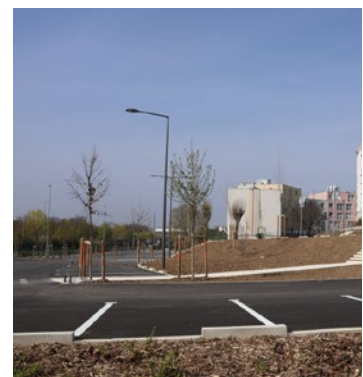
Au-delà du bitume, l'accent a été mis sur l'esthétique : de nouvelles plantations ornent les espaces et les flux piétons sont désormais mieux sécurisés face aux voitures.
