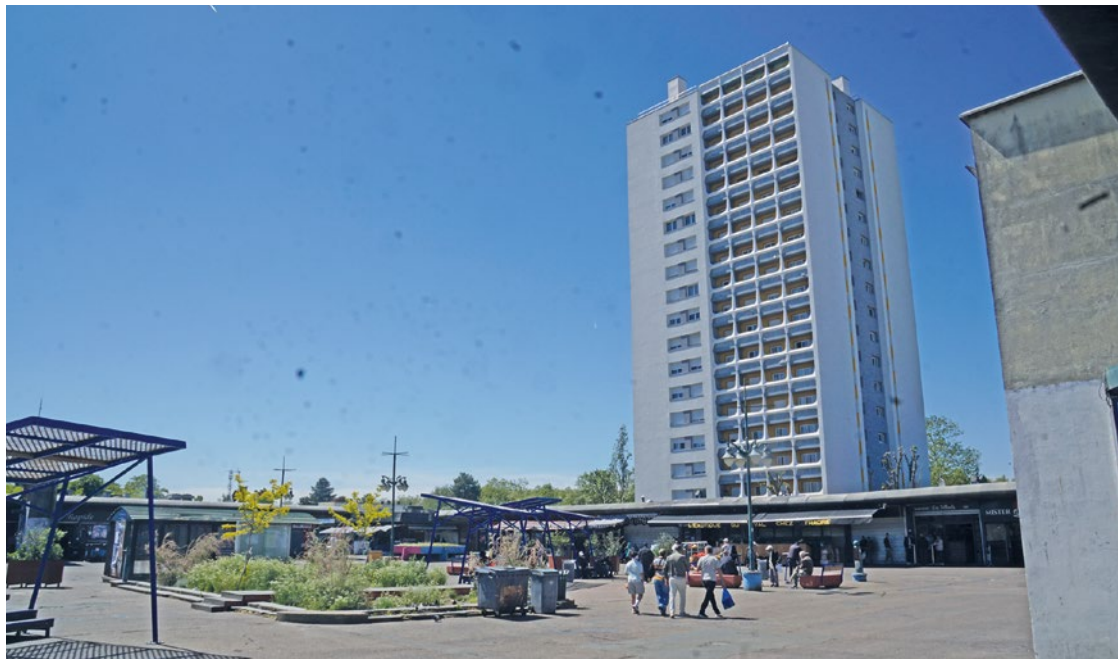
La dalle du Val-Fourré, élément central de ce quartier.
