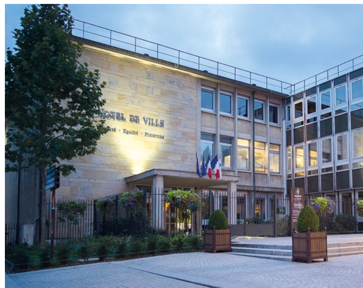
La Ville s'étonne de voir ces dégradations durer dans le temps.
