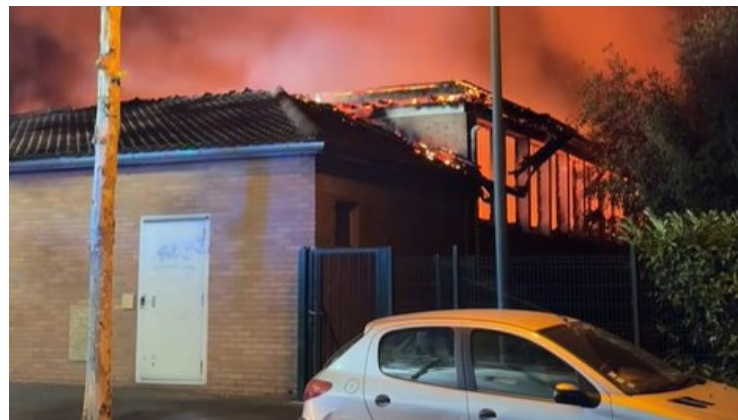
La toiture de la salle polyvalente a été complètement détruite.
