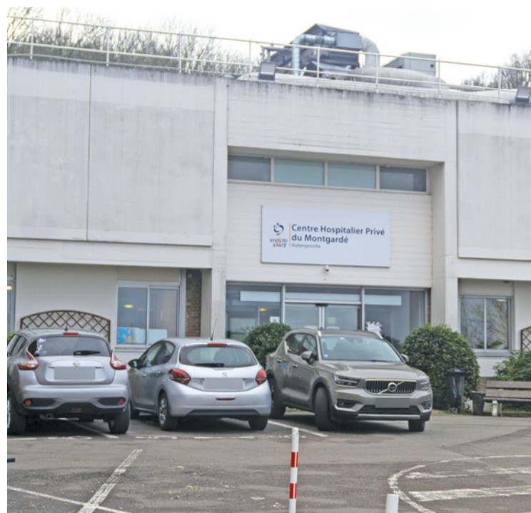
Une trentaine de pompiers ont été dépêchés sur place.
